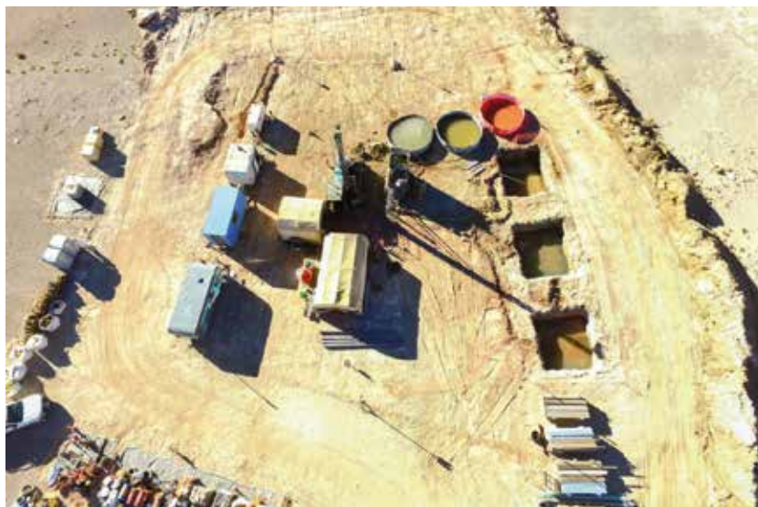
La compañía proyecta cuatro nuevos pozos de producción y trabajos de desarrollo del sitio.
