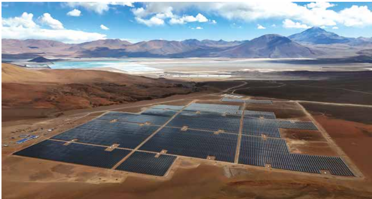
Parque solar que abastece con energía renovable al proyecto Mariana.
