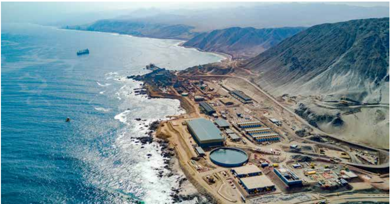
Panorámica de las plantas desalinizadoras en Puerto Coloso.
