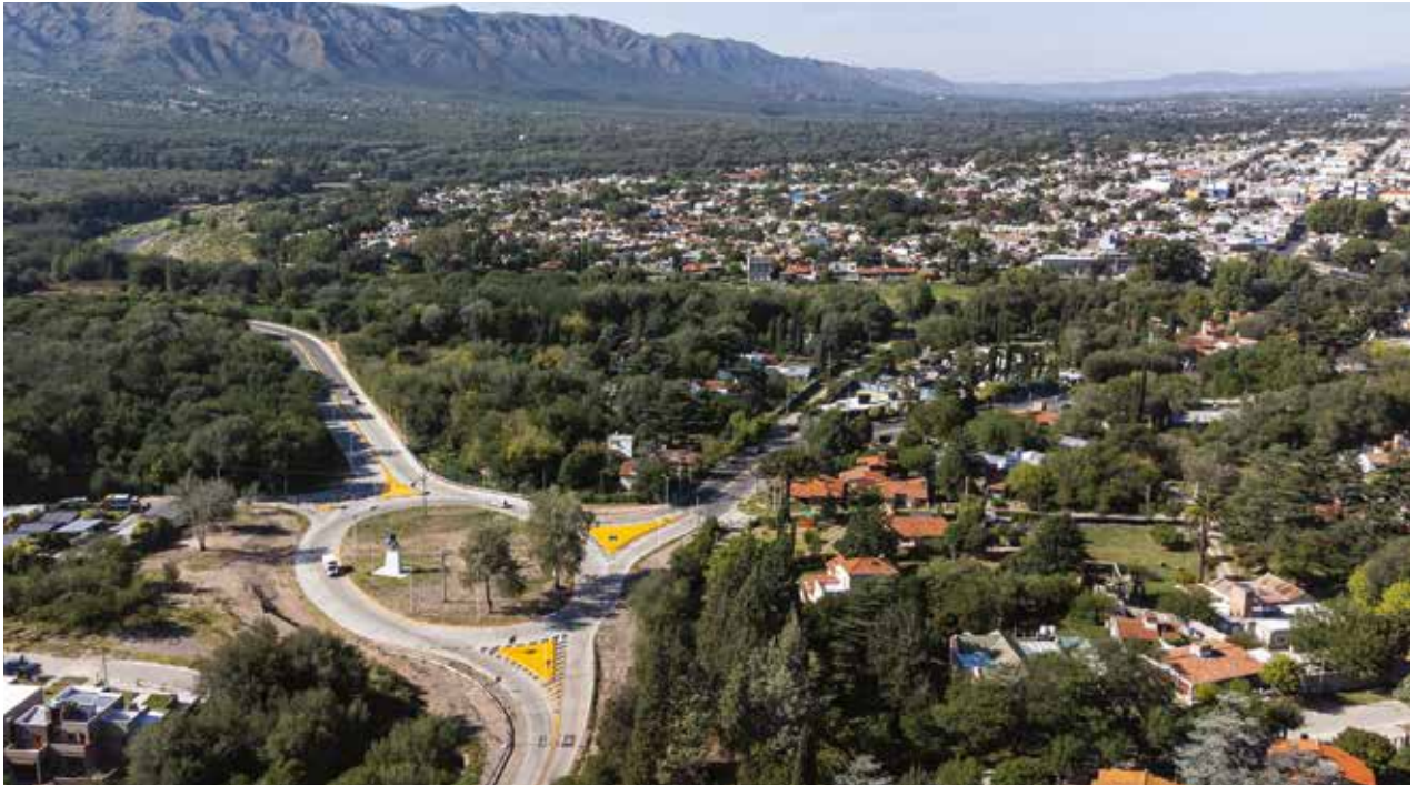
Obra: Intersección de R. N. N°38 con R.P. N°54 y Costanera de Cosquín (rotonda) - Departamento: Punilla - Provincia de Córdoba
