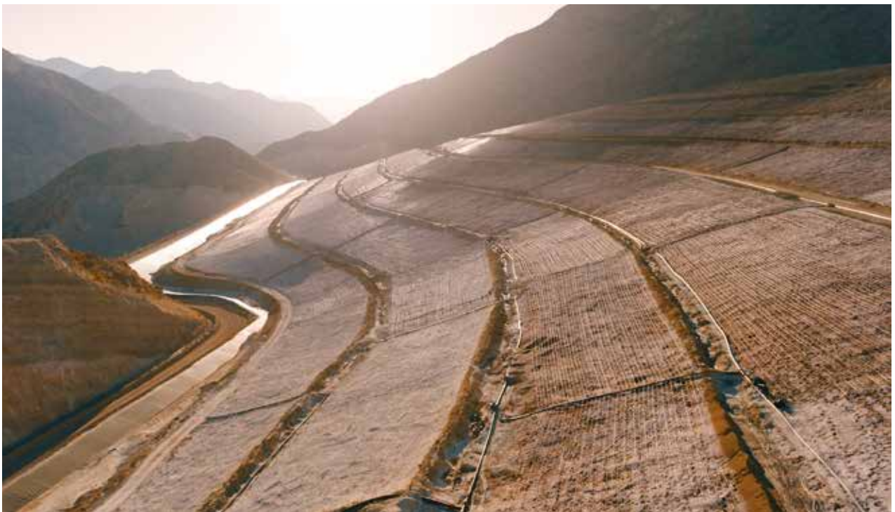
La operación histórica, basada en lixiviación en pilas, está en etapa de producción residual.
