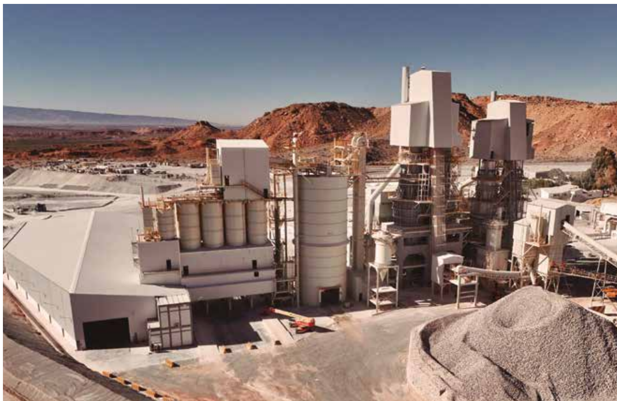
Vista panorámica de las instalaciones de Calidra en La Laja.
