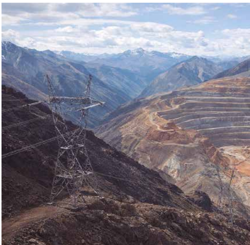
Una falla en una red en altura no tiene el mismo impacto que en un entorno accesible.
