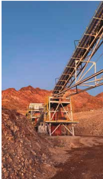
Trituradora Primaria de mina Casposo.
