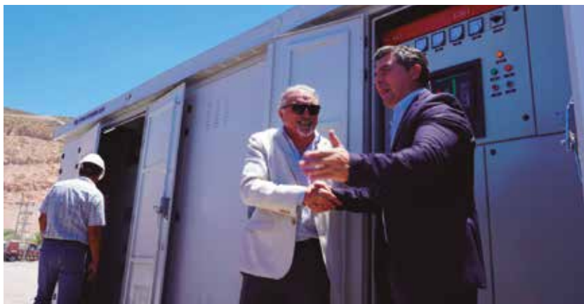
El Ing. Raúl Cabanay y el gobernador de San Juan, Marcelo Orrego, en la inauguración del parque fotovoltaico
