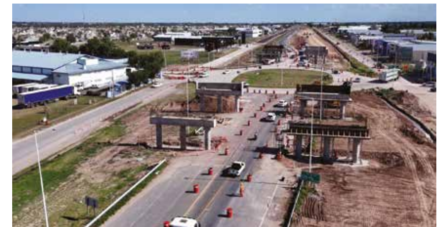
Obra: Duplicación de Calzada y Viaducto en Av. de Circunvalación de Río Cuarto (A-005) - Tramo: Calle General Molina - Calle Pcia. de La Rioja - Departamento Río IV - Provincia de Córdoba
