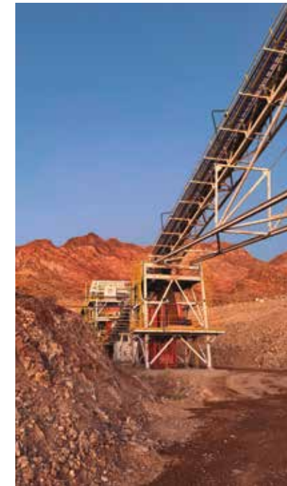
Trituradora Primaria de mina Casposo.
