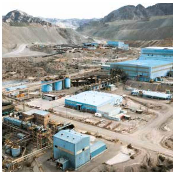
Panorámica de las instalaciones de Bajo de la Alumbraera
