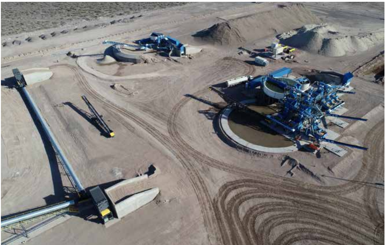
Plantas de lavado de arena de NRG Argentina en la provincia de Río Negro
