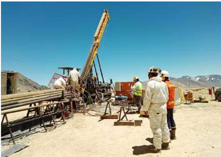
Tareas de perforación en El Perdido (Departamento Malargüe)
