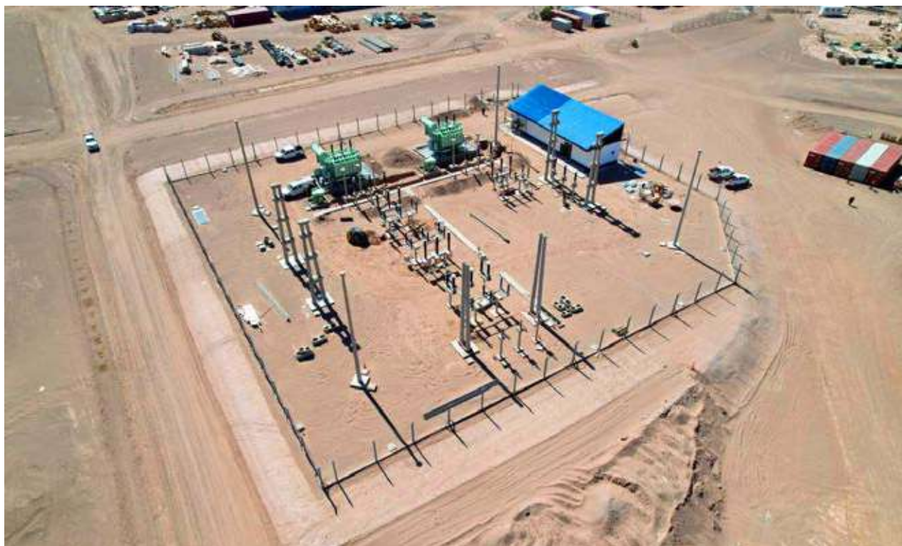
Catamarca: construcción de la nueva línea de alta tensión de 132 kV que unirá Tinogasta con Fiambalá
