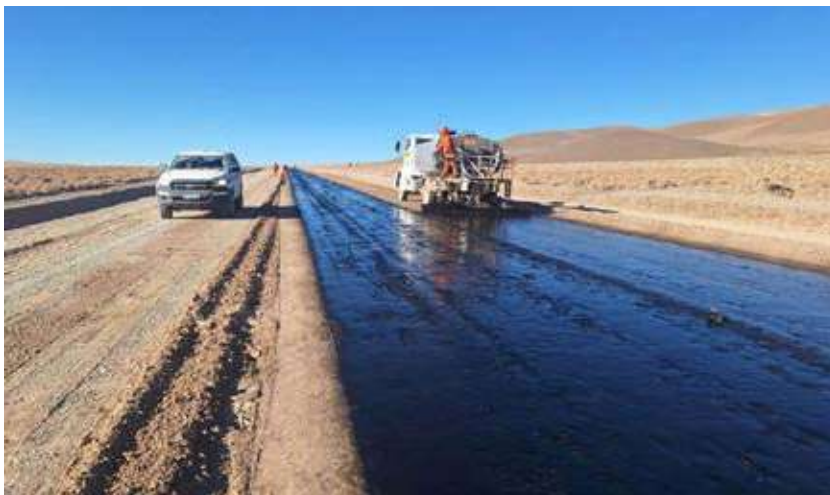
Tareas de pavimentación en la RP 27, acceso a Salar del Rincón y Tolar Grande, provincia de Salta
