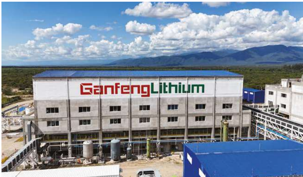
Planta de procesamiento de cloruro de litio en General Güemes (provincia de Salta)
