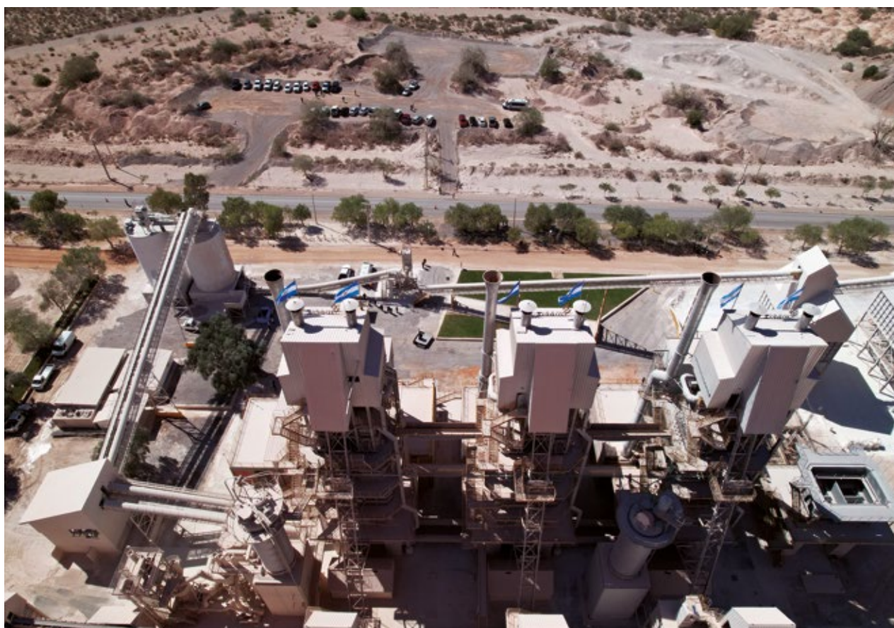
Panorámica de los tres hornos actuales de Caleras San Juan
