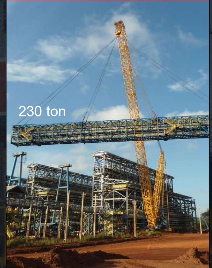
Grúa de 1400 ton
