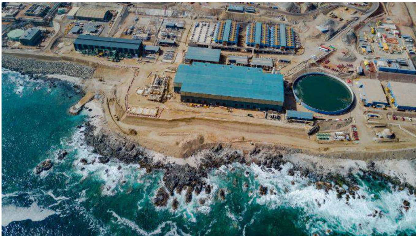
Minera Escondida EWS En operación desde 2013
